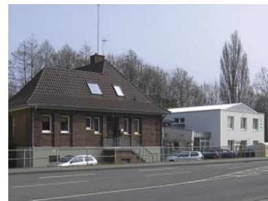
Neu- und Umbau DRK Kreisgeschäftsstelle, Steinfurt
