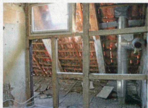
Hier war ein Badezimmer eingerichtet. Wie saniert werden muss, erfolgt in enger Absprache mit der Denkmalbehörde.
